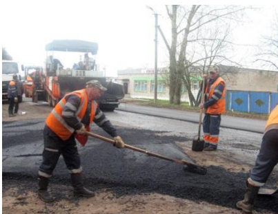
Ремонт местных дорог
