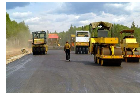
Строительство местных дорог
